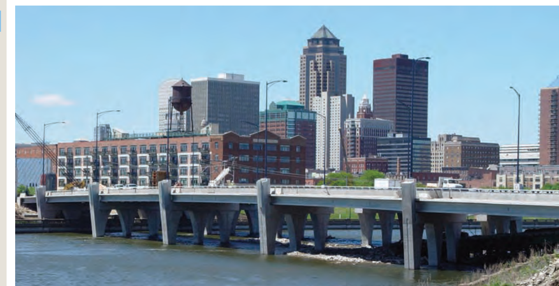
La construcción de los puentes del SE Connector se acerca a su término
